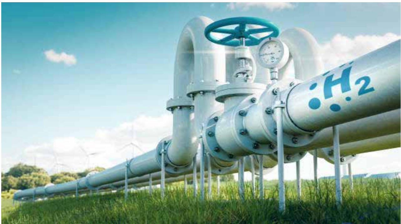
Impianto di distribuzione dell'idrogeno
